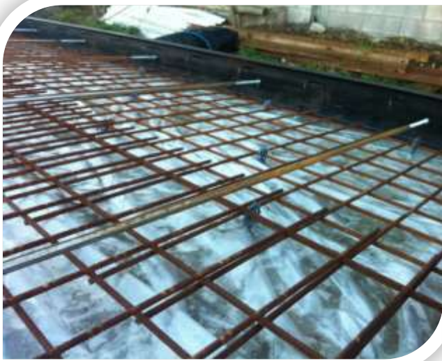
Module prêt à être coulé
