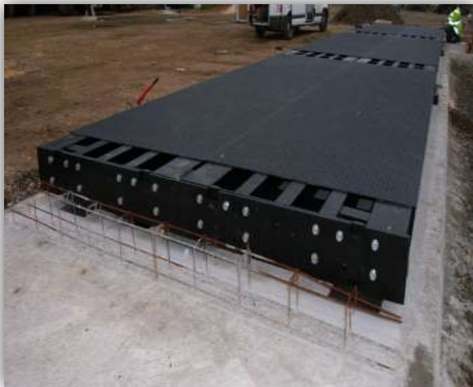
Pont bascule hors sol, montage en cours
